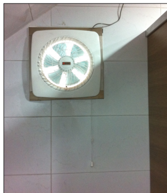
〈화장실 내 환풍기 설치〉
