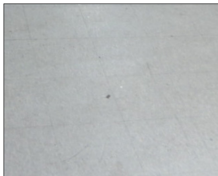
〈작업장에 시공된 데코타일〉
