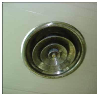
〈천장형 배기_플라스틱재질(좌), 스테인리스재질(우)〉
