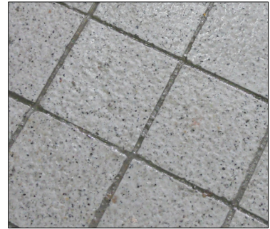
〈바닥에 시공된 석재타일〉
