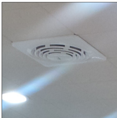
〈천장형 배기_플라스틱재질(좌), 스테인리스재질(우)〉
