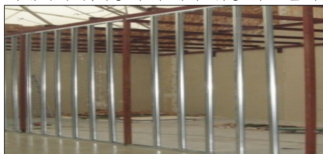
〈메탈스터드 시공 모습〉
